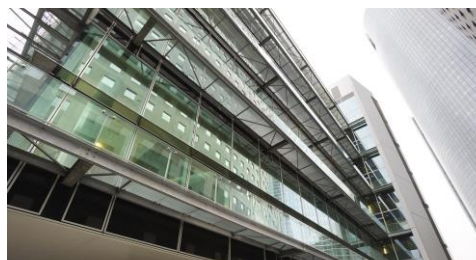
Immeuble Basalte - LA DEFENSE (92)
